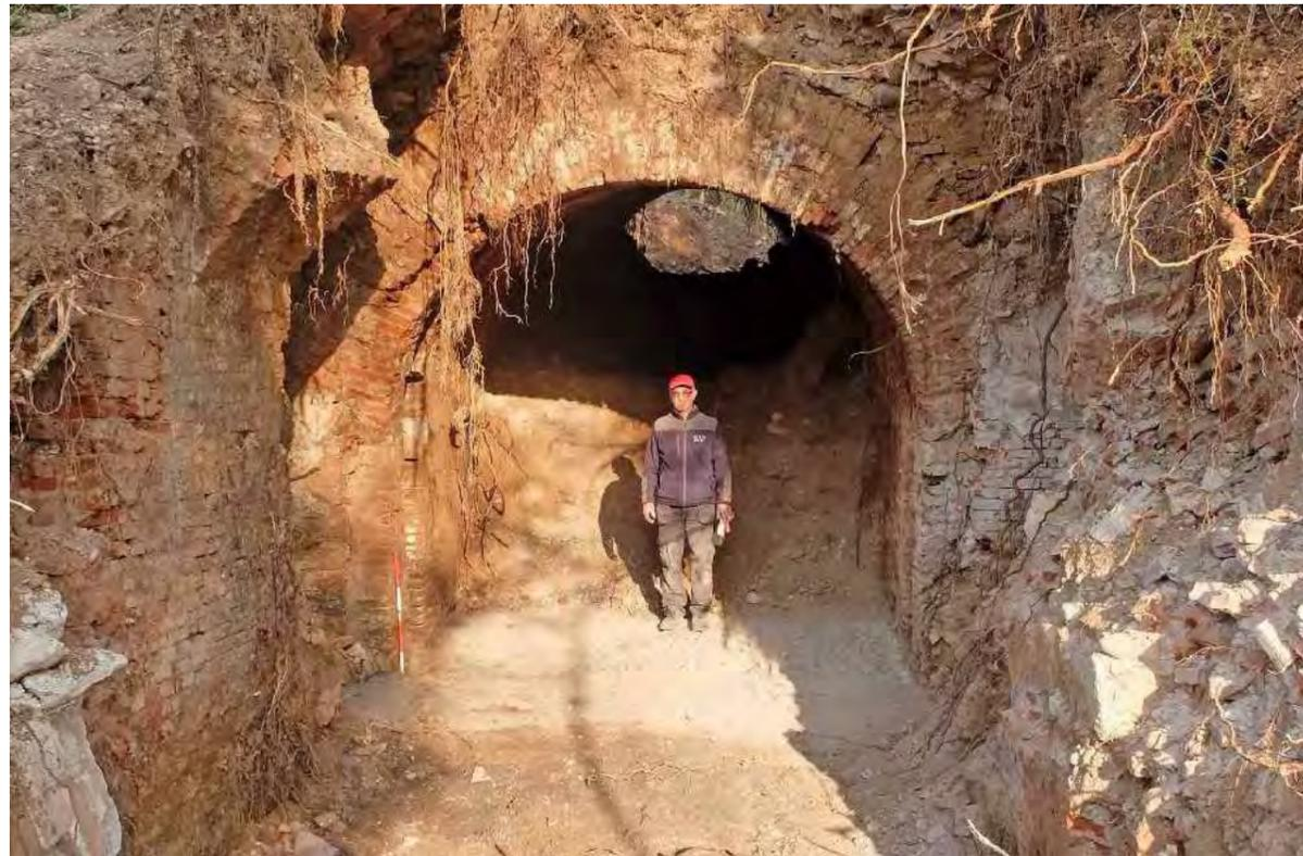
Panoramica dell'ingresso esterno alla poterna orientale devastata all'imbocco, ma ben conservata verso l'interno, in cui la volta è rimasta solidamente intatta per alcuni metri, permettendo il collegamento diretto con il piazzale centrale
