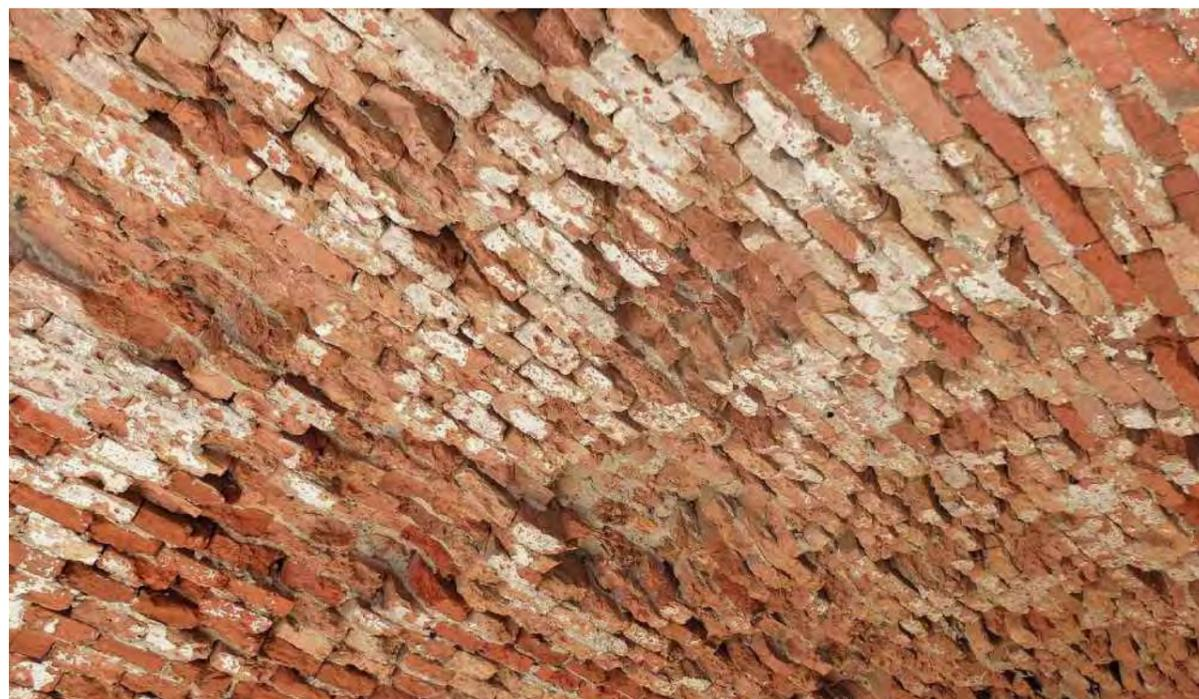
Particolare della volta della poterna orientale visibilmente intaccata dalle esplosioni in superficie, ma ancora solidamente conservata nella porzione centrale della struttura
