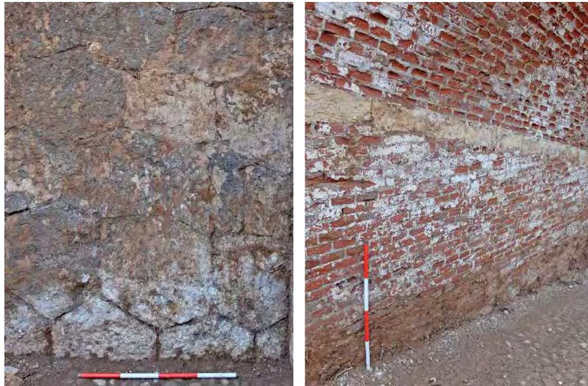
Particolari di un tratto di muratura in opera poligonale e in mattoni con inserti lapidei, completamente conservati
