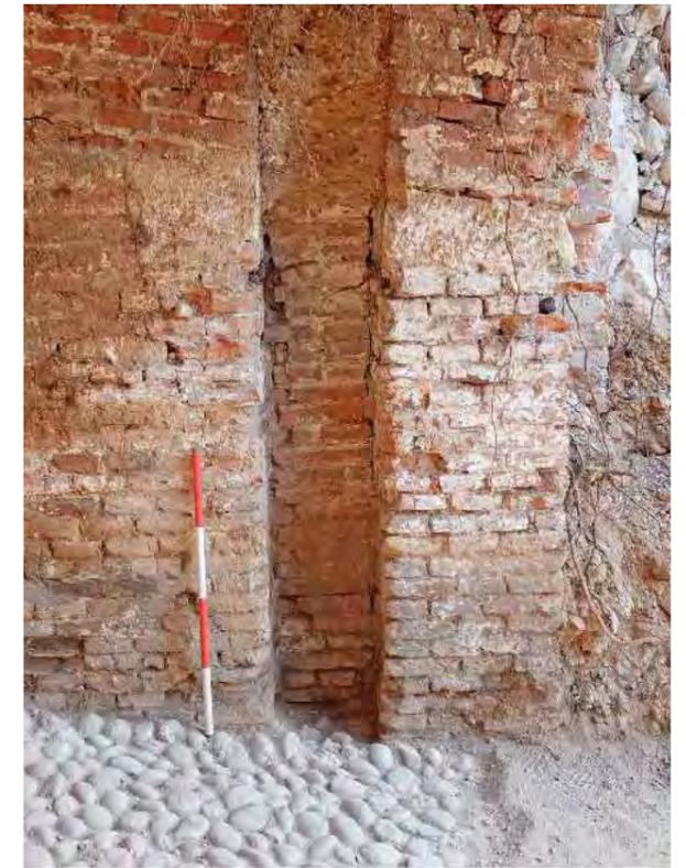
Particolari dell'imbocco esterno della poterna orientale, pesantemente compromesso dalle deflagrazioni, e dal paramento della porzione più interna, in cui la struttura appare ancora ben conservata
