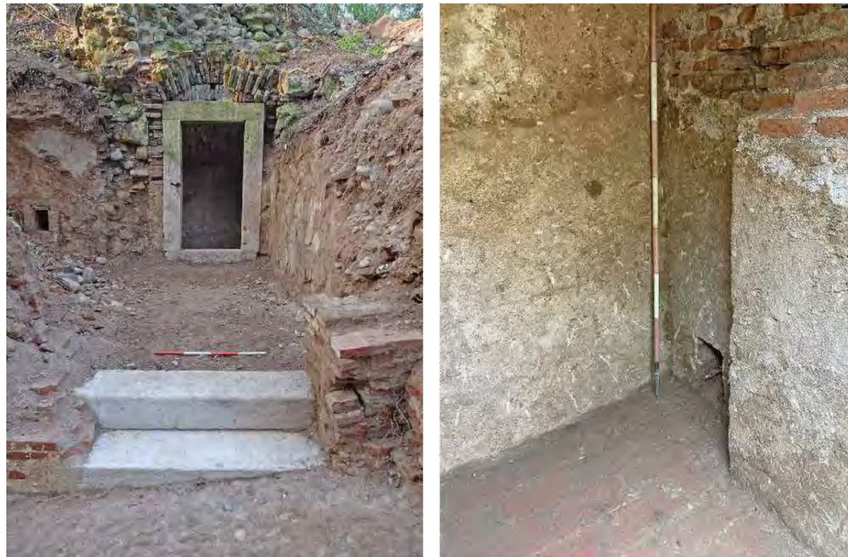
Particolari dell'ingresso - posto sul fianco meridionale della poterna - alla polveriera e dell'interno, con la pavimentazione in cotto le pareti ancora intonacate
